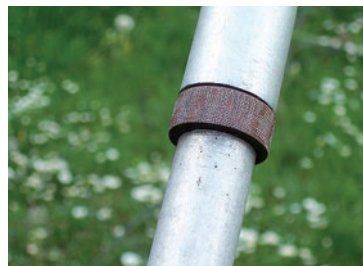
Rurki łączone są za pomocą elementu z tekstolitu
